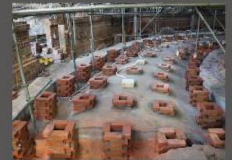
ヴォールト裏のコンクリート補強 Reinforcement was installed on the vault's upper surface
