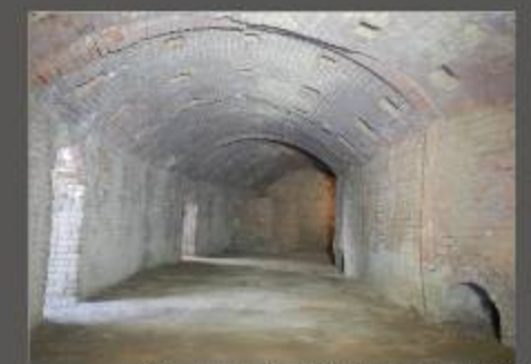
ヴォールト裏の見えないコンクリート補強 Reinforcement is hidden above the vault
