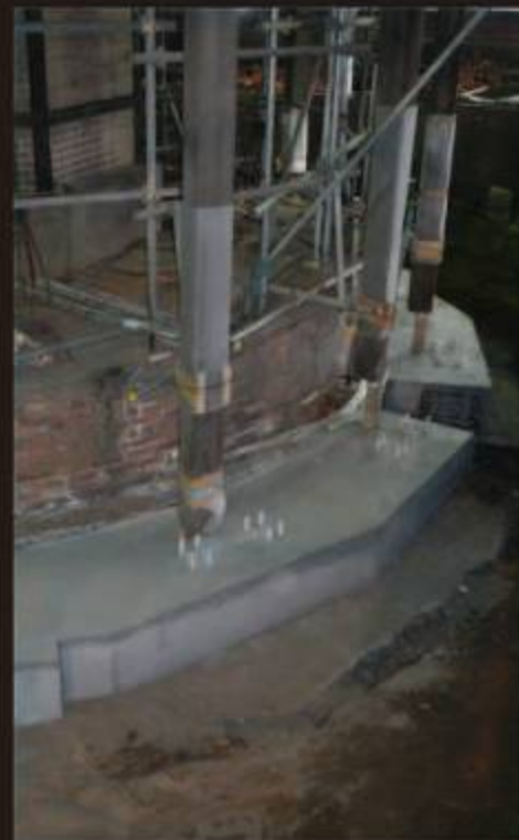
補強のコンクリートリング Concrete ring reinforcement
